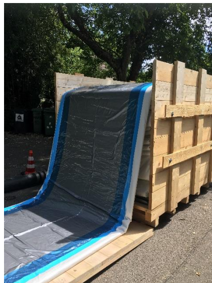
Étape mise en place gaine
